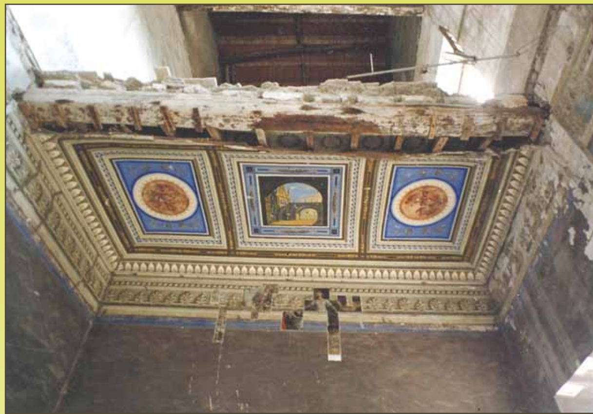
Il Palazzo prima dei restauri degli anni '90: particolare dei soffitti decorati
